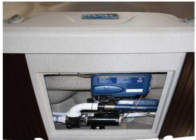
裝置維修孔位於頂端控制面板下方
